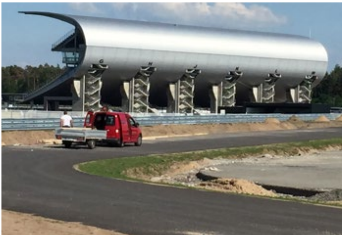
Foto: Leder Bau GmbH beim Umbau Hockenheimring
